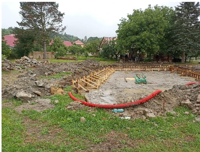
STAV V PRŮBĚHU REALIZACE:
